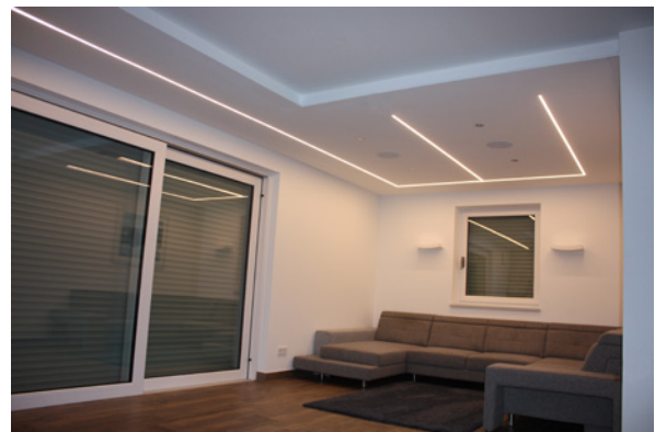
Prefabricated gypsum panels with integrated aluminium profile in modular design // Gips-Fertigteil-Paneele mit integriertem Aluprofil in Modulbauweise
