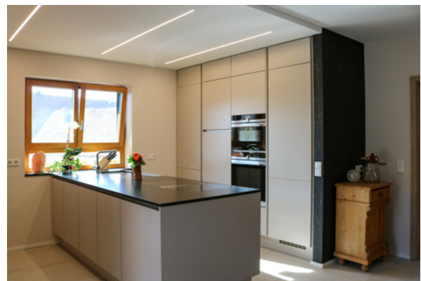
Prefabricated gypsum panels with integrated aluminium profile in modular design // Gips-Fertigteil-Paneele mit integriertem Aluprofil in Modulbauweise
